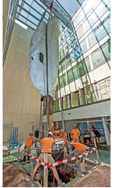
Einpflanzung des 12 Meter hohen Baumes im Lichthof des Neubaus.
